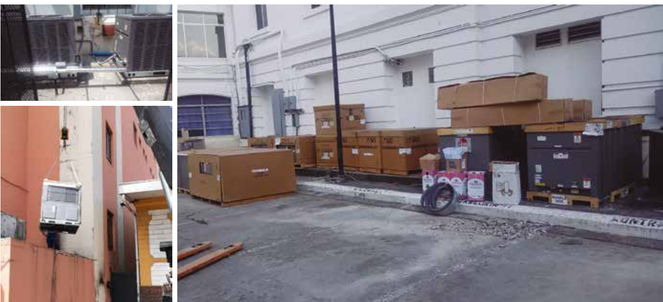
Cambios de aires acondicionados centrales
