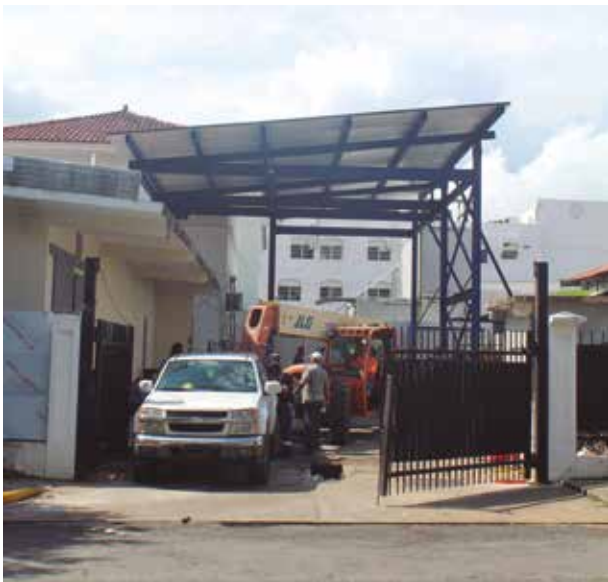
Construcción de estructura y techo para el área de desechos hospitalarios.
